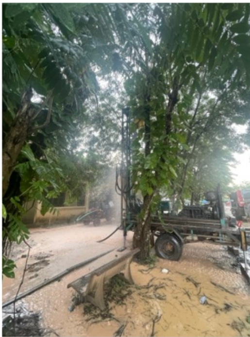
Brunnen in einer Schule bohren.
