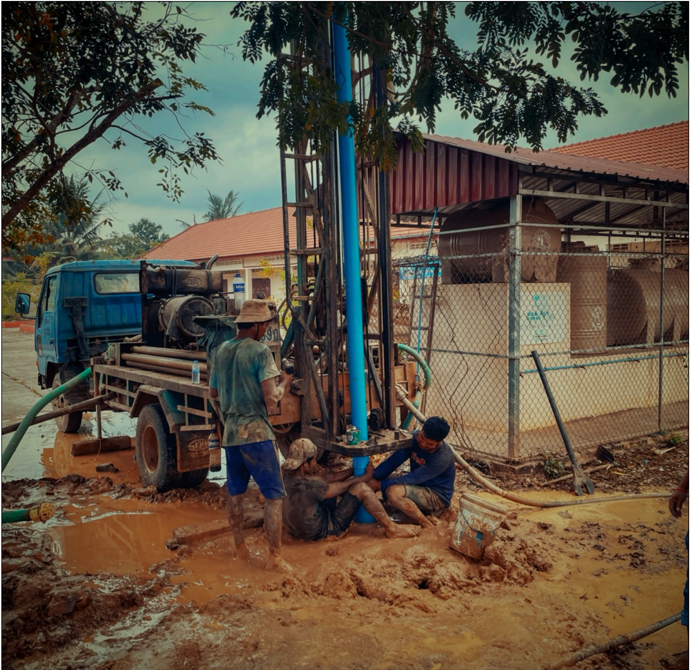
Ein Brunnen wird in einer Primarschule gebohrt.
